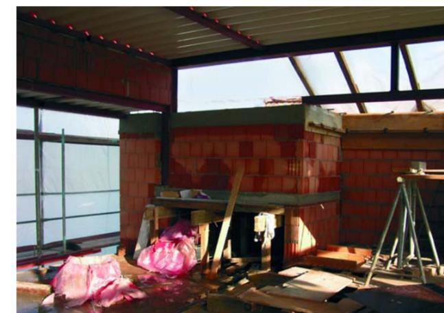
Die Ausfachtung des Fachwerkr Rahmens mit Porotonziegelmauerwerk
