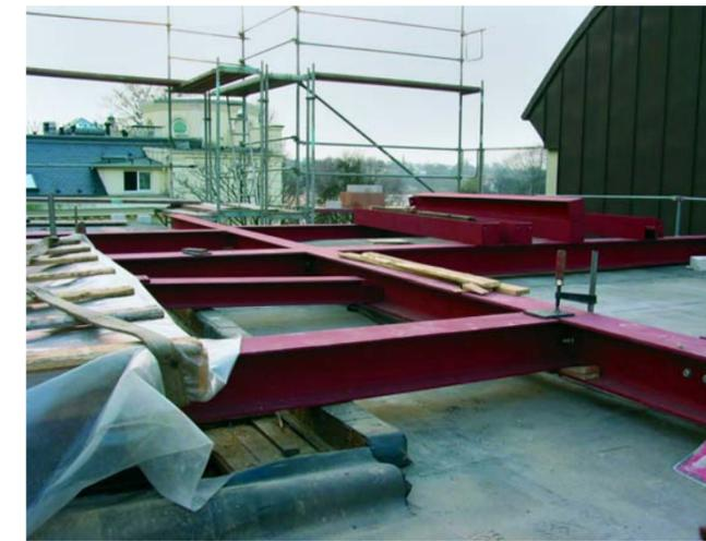
Ein Stahlträger wird auf der alten Rohdecke montiert.
